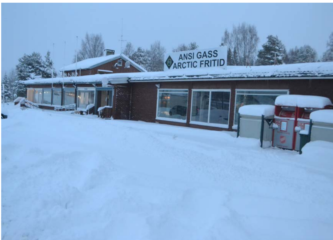
Det nokså slitne forretningsbygget i Berkåk sentrum vil etter all sannsynlighet bli erstattet av moderne leiligheter. Foto: Jan Inge Flå
